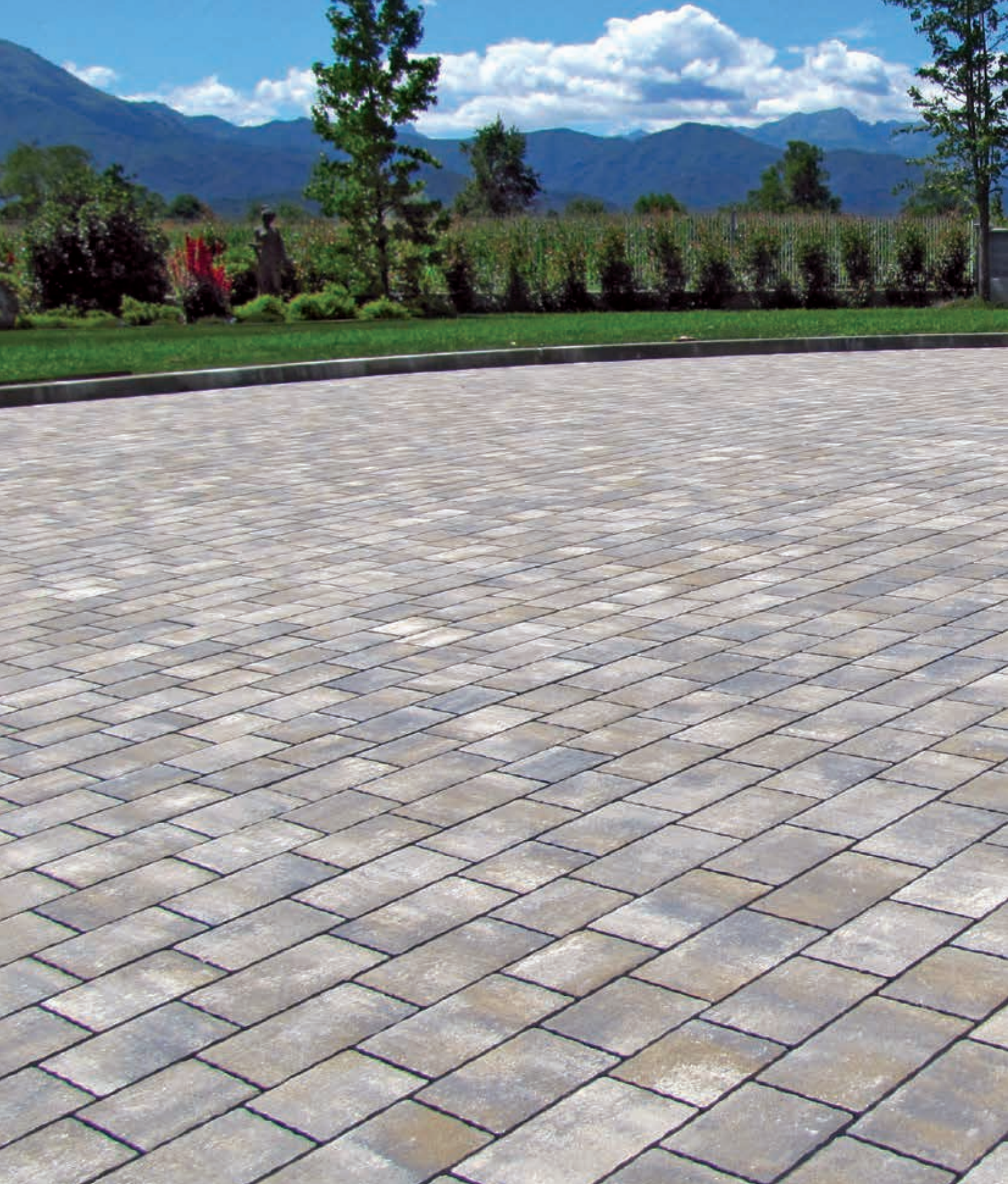
TREPEZZI couleur LUSERNE - scellement du joint avec sable polymère
