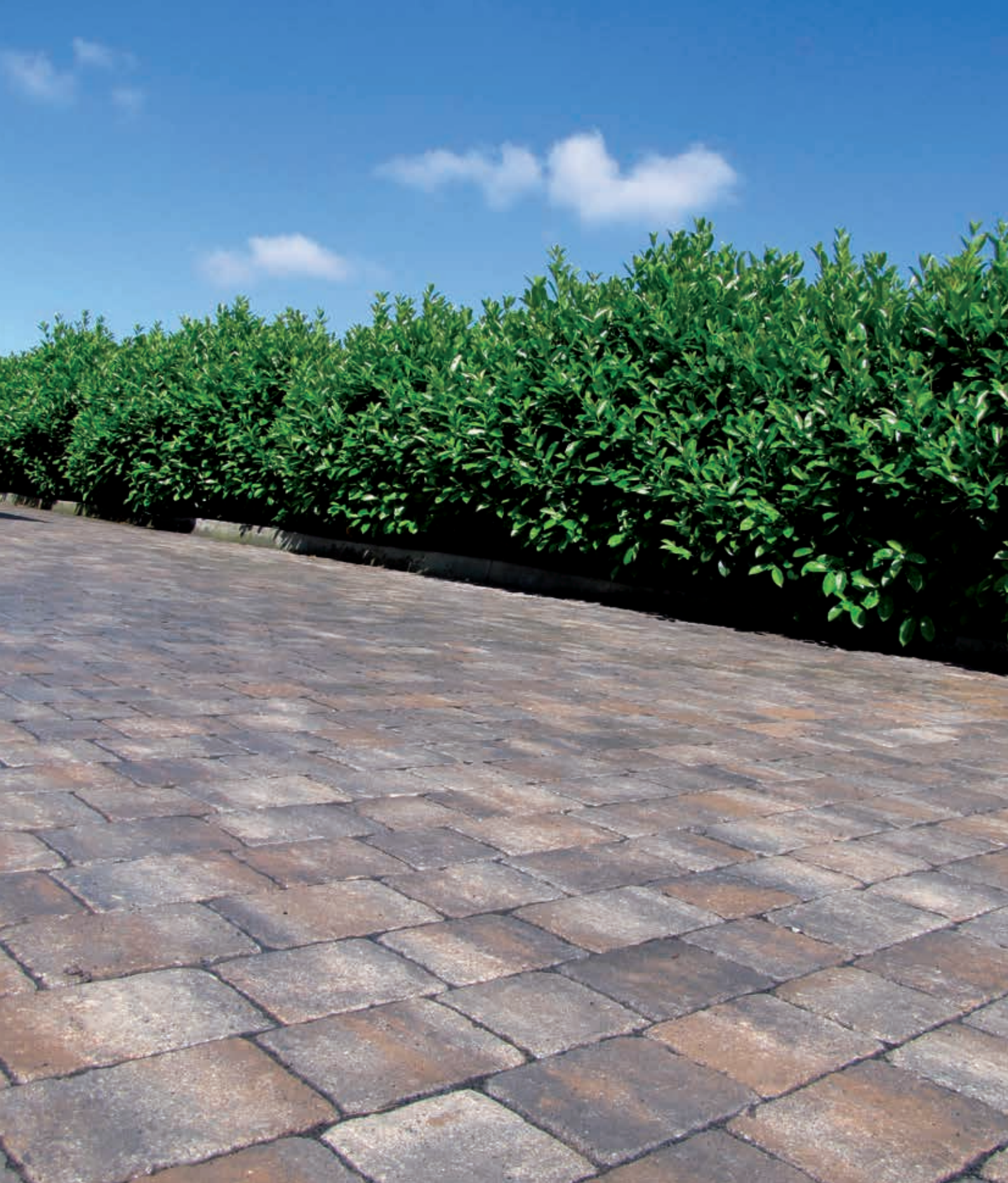
VIA SALARIA VIEILLI couleur MIX ORANGE - scellement du joint avec sable polymère
