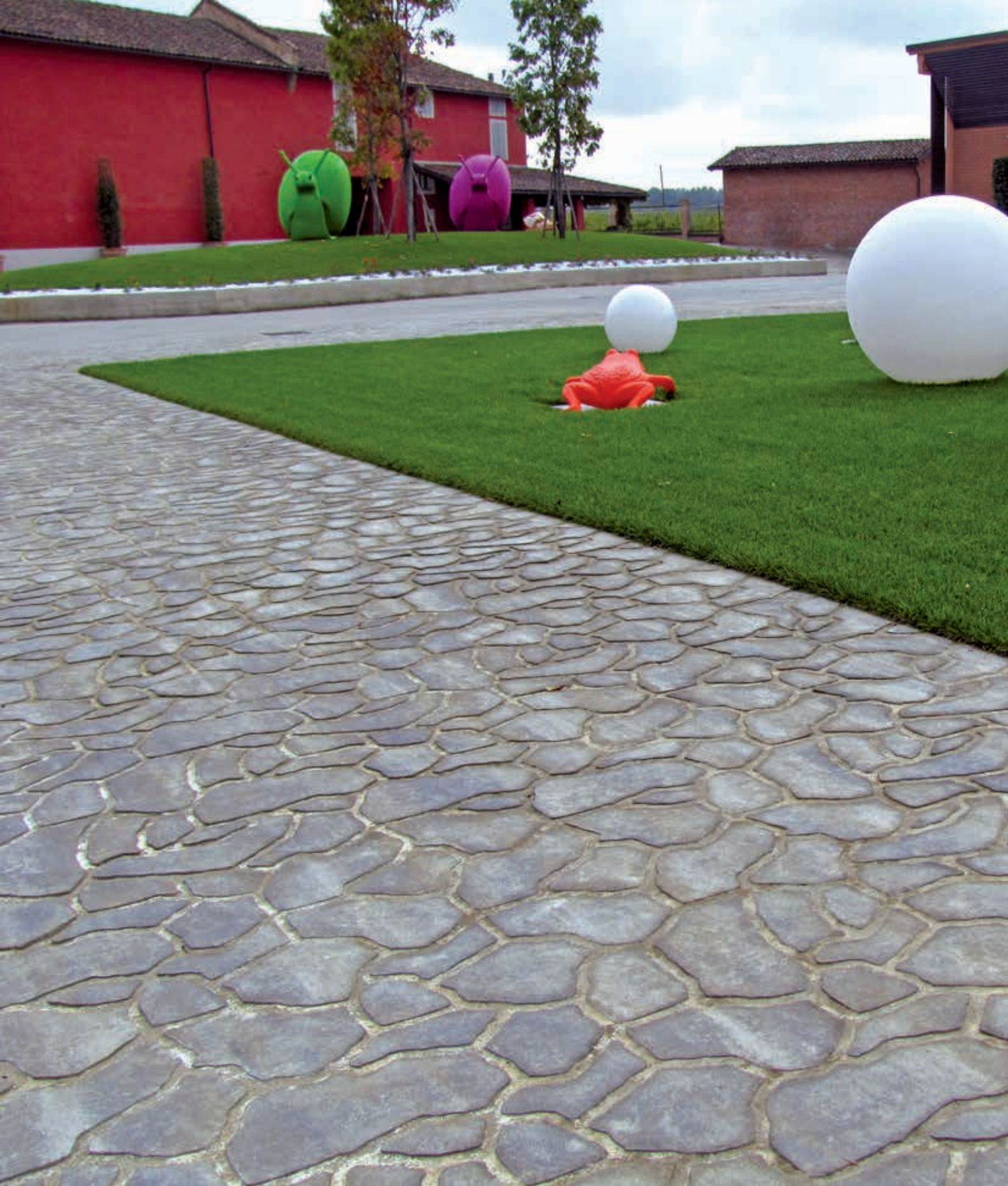
OPUS couleur LUSERNE – scellement du joint avec sable et ciment
